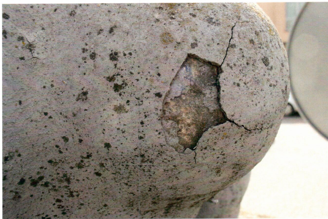
SIEMIATYCZE, RZEŹBA SFINKSA LEWA – CZĘŚCIOWO ODSPÓJONA ZACIERKA CEMENTOWA, POD NIĄ WIDOCZNE WCZEŚNIEJSZE ZACIERKI I POWIERZCHNIA PIASKOWCA Z CIEMNYMI NAWARSTWIENIAMI
