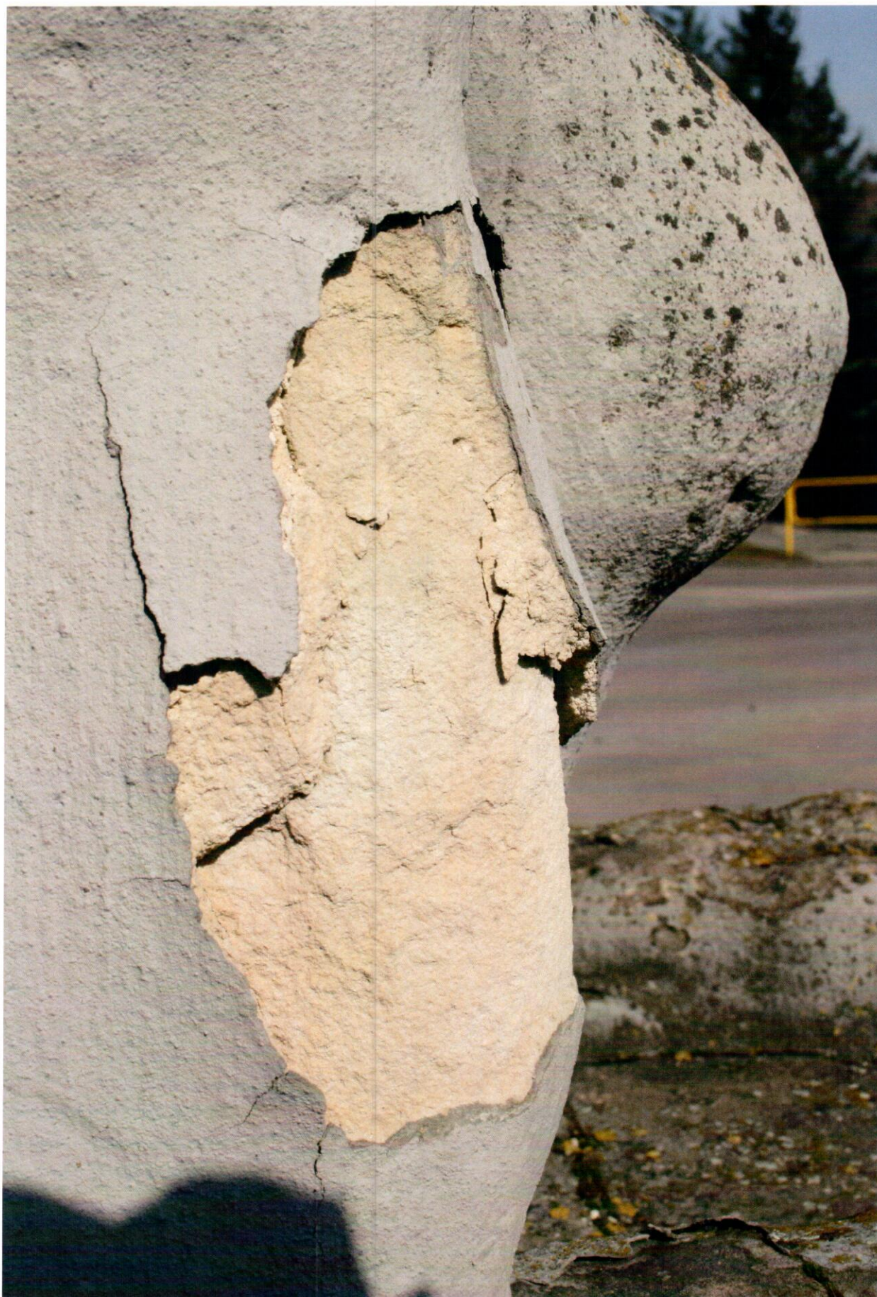
SIEMIATYCZE, RZEŹBA SFINKSA PRAWA – DESTRUKCJA PIASKOWCA POD GRUBĄ WARSTWĄ ZACIERKI CEMENTOWEJ
