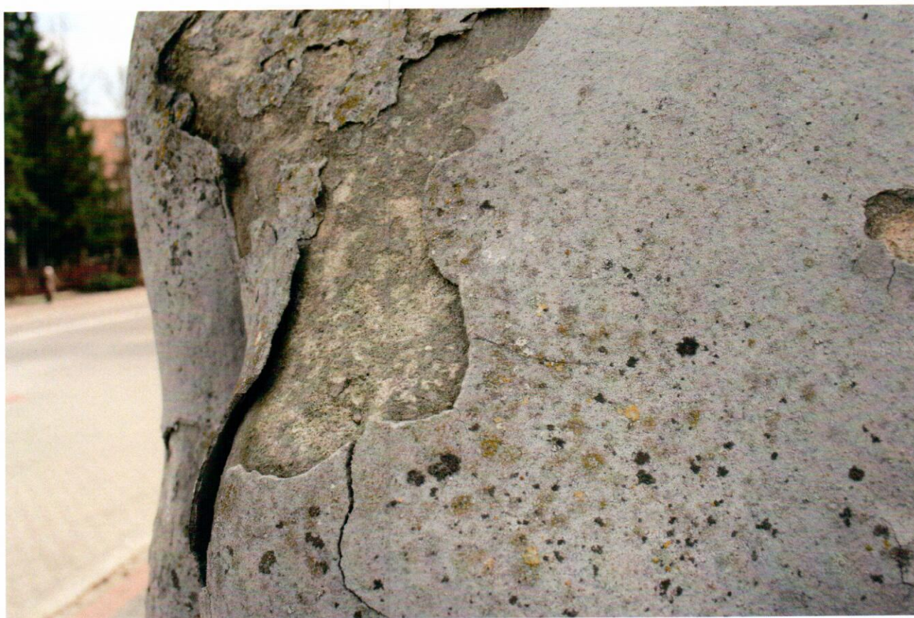
SIEMIATYCZE, RZEŹBA SFINKSA LEWA – CZĘŚCIOWO ODSPÓJONA ZACIERKA CEMENTOWA, POD NIĄ WIDOCZNE WCZEŚNIEJSZE ZACIERKI I POWIERZCHNIA PIASKOWCA Z CIEMNYMI NAWARSTWIENIAMI
